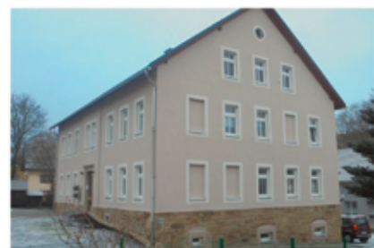
Fassadensanierung in Sehmatal-Sehma
