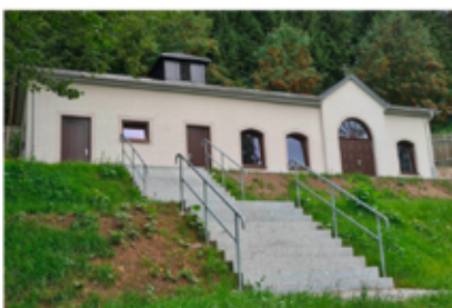
Sanierung der Trauerhalle in Niederschmiedeberg
