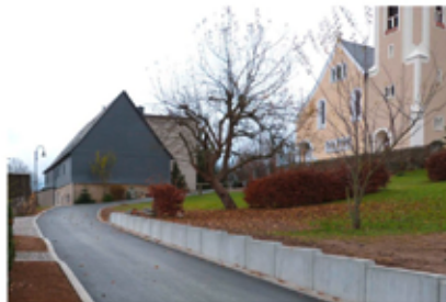
Ausbau des Kirchsteiges in Neundorf
